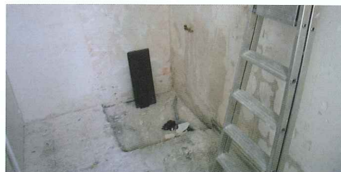
Une fois désossée, il reste dans la salle d'eau une réservation de 8 cm correspondant à l'ancien receveur. Elle sera utile pour intégrer le caniveau et réaliser la douche de plain-pied.
