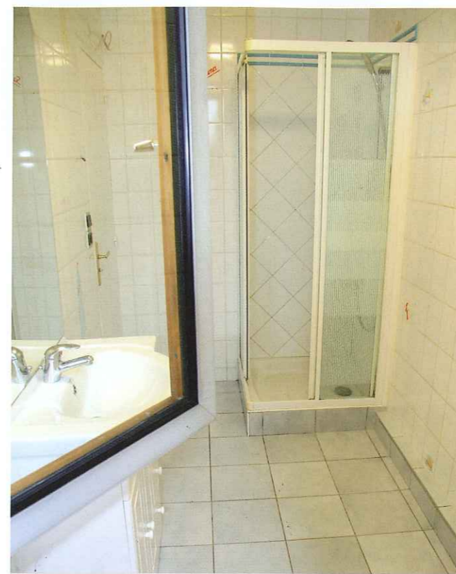
Avant les travaux de rénovation, la salle d'eau est très classique : une cabine de douche avec receveur, un lavabo et une cuvette de WC.
